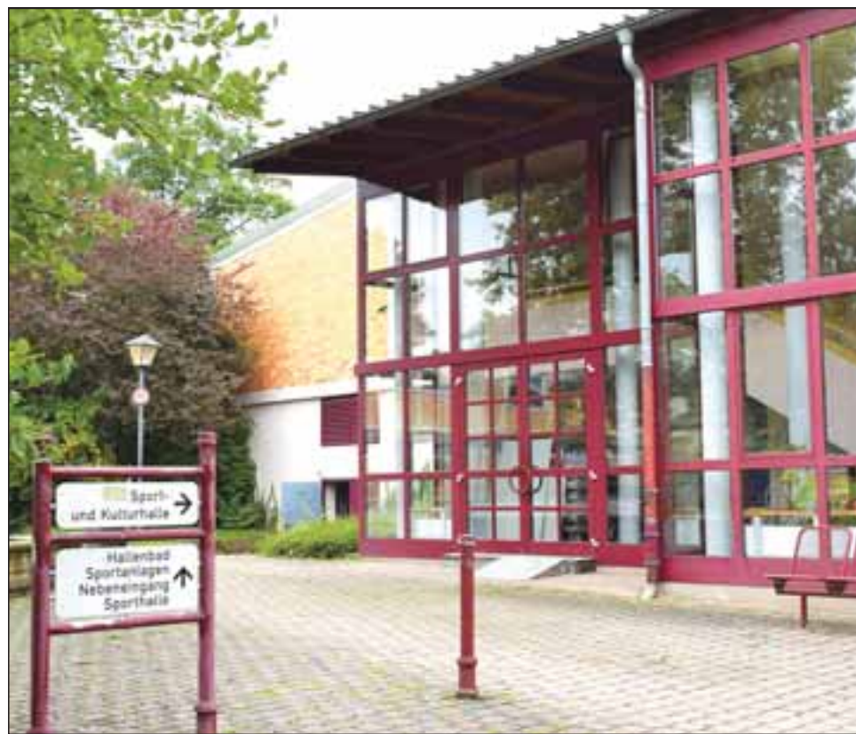
Die Sanierung der Sport- und Kulturhalle ist das größte Projekt der nächsten Jahre. Foto: Trilsbach
